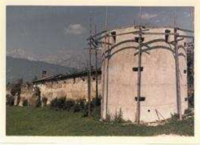
Südwest-Turm in Renovierung
