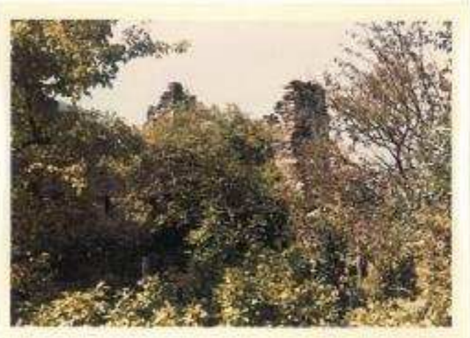
Nordwest-Turm der Mauer
